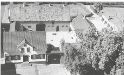
▲ Die alte Stallanlage des Gestüts Schlenderhan.
