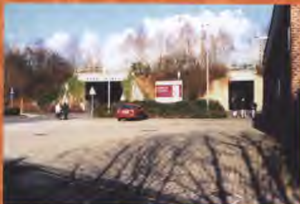
Brücke und Fußgängerdurchgang Frenzerstraße
